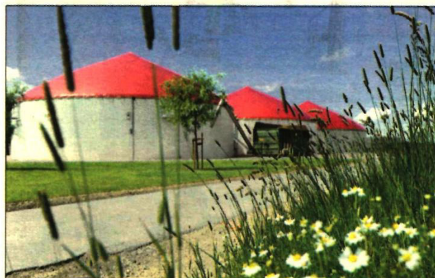
Biogasanlage auf der Nordseeinsel Nordstrand. Die Bottiche müssen nicht hässlich sein. Werden sie außerdem mit mehreren Pflanzenarten beschickt, kann sich niemand über Monokulturen aufregen.
